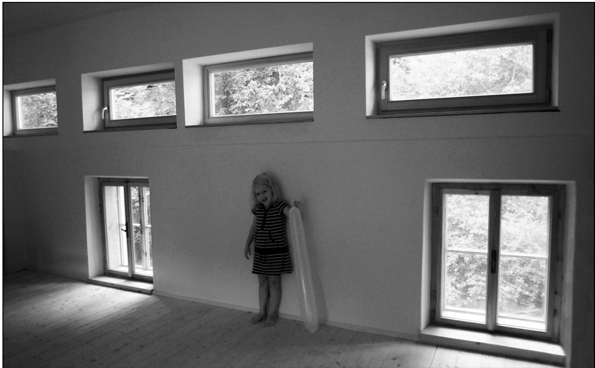
**Abbildung 1: ungewöhnliche Fensteranordnung – Fixverglasungen, Drehkipplügel und Kastenfenster<sup>1</sup>**
