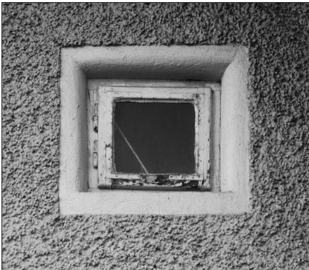
**Abbildung 2: kleines Giebelwand-Dachbodenfenster mit abgerundeter Leibung<sup>2</sup>**
