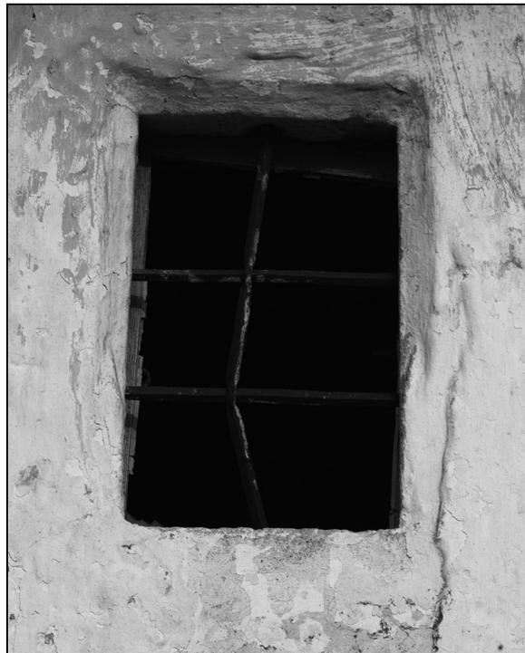
**Abbildung 3: Glaslose Maueröffnung mit Fenstergitter und abgeschrägter Leibung<sup>5</sup>**
